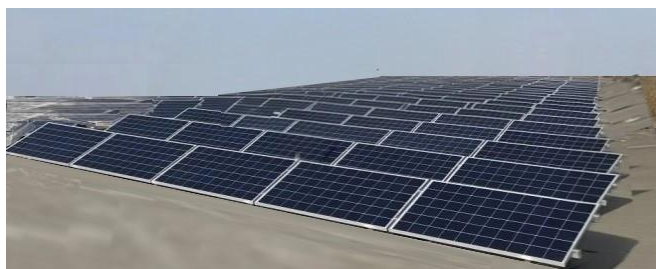
Příklad modulární FVE, která může být provozována jako otočná FVE východ/západ s vyšší účinností, nebo jako standardní fixní FVE
