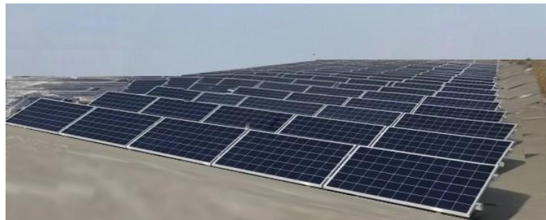
Obr. 5 Příklad modulární FVE, která může být provozována jako otočná FVE s vyšší účinností, nebo jako standardní fixní FVE
